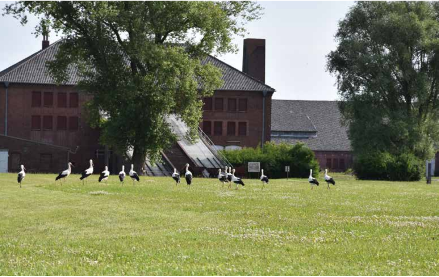
Südansicht des ehemaligen Klinkerwerks mit der Rampe
